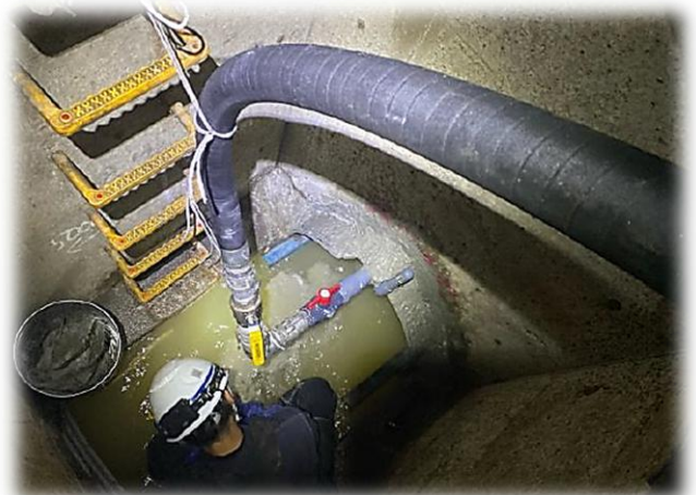
札内幹線下水道管更生工事の様子
