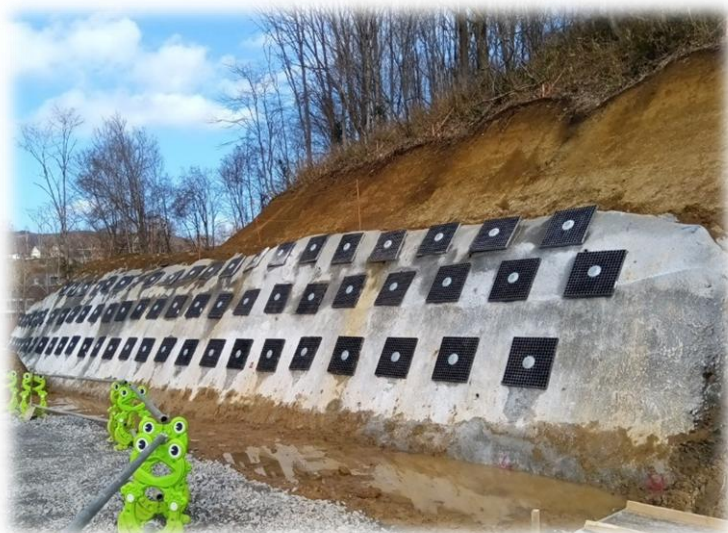
ヒラフ谷ホテル開発工事現場の様子
